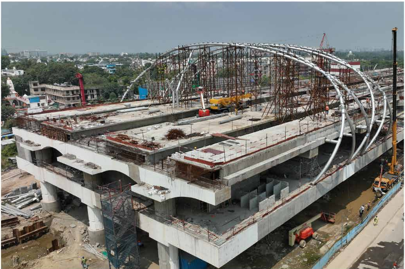
आकार लेने लगा सराय काले खां आरआरटीएस स्टेशन जल्द बनेगा ट्रांसपोर्ट हब
