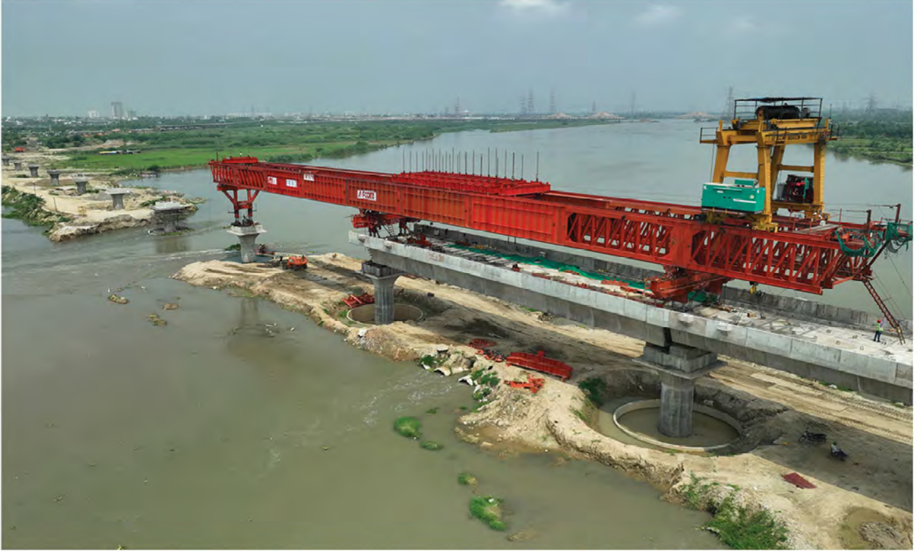
यमुना पर निर्माणाधीन आरआरटीएस वायाडक्ट का निर्माण पूर्ण होने के करीब
